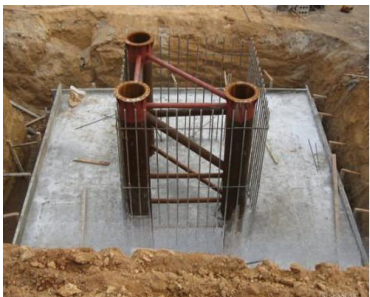
④ 철탑 기초 설치
