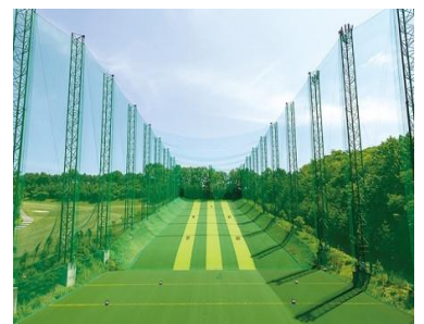
⑨ 설치 완료
