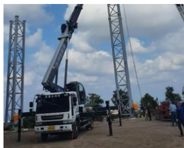
⑧ 철탑 설치
